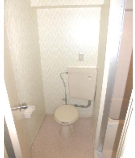
UB横にある脱衣所兼洗濯機置場にトイレを移設するスペースがなく、考慮した結果、欧米風に洗濯機置場をキッチン横に移設。空いたスペースにユニットバスからトイレを移設。洗濯機用に元々あった排水管、給水管を利用して設置しました。リフォームの場合は水回り設備の設置を安価で簡単にやるには場所を十分に考慮して施工する事がポイントです。便器を交換することなく利用していますので、これも費用軽減となります。まさにアイデア施工です。
